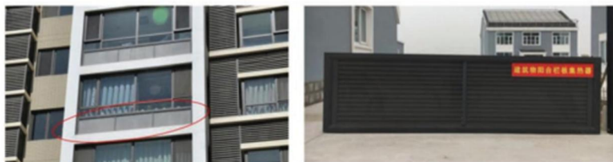
图9.1 建筑物阳台栏板陶瓷太阳能热水器
